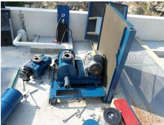
Figura 70. Mantenimiento al drenaje de aguas negras
